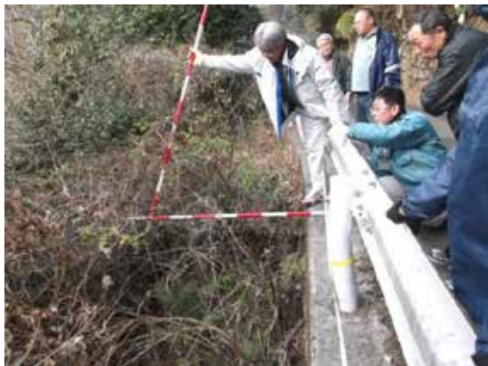
写真-4 現地で工法や延長を協議
